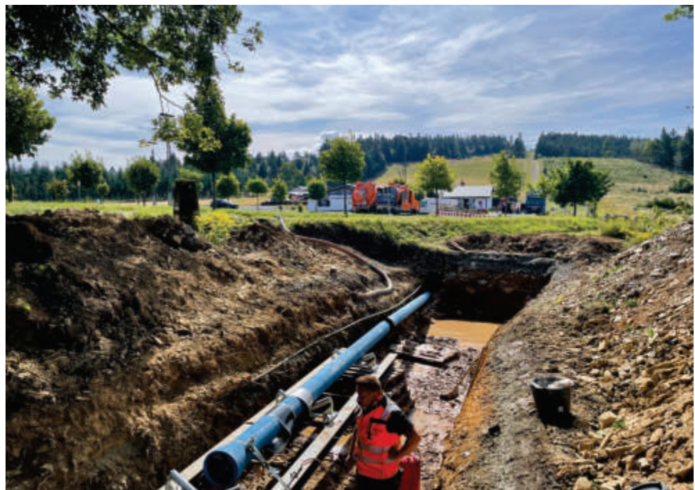
Bauarbeiten am „Südlichen Lückenschluss“
