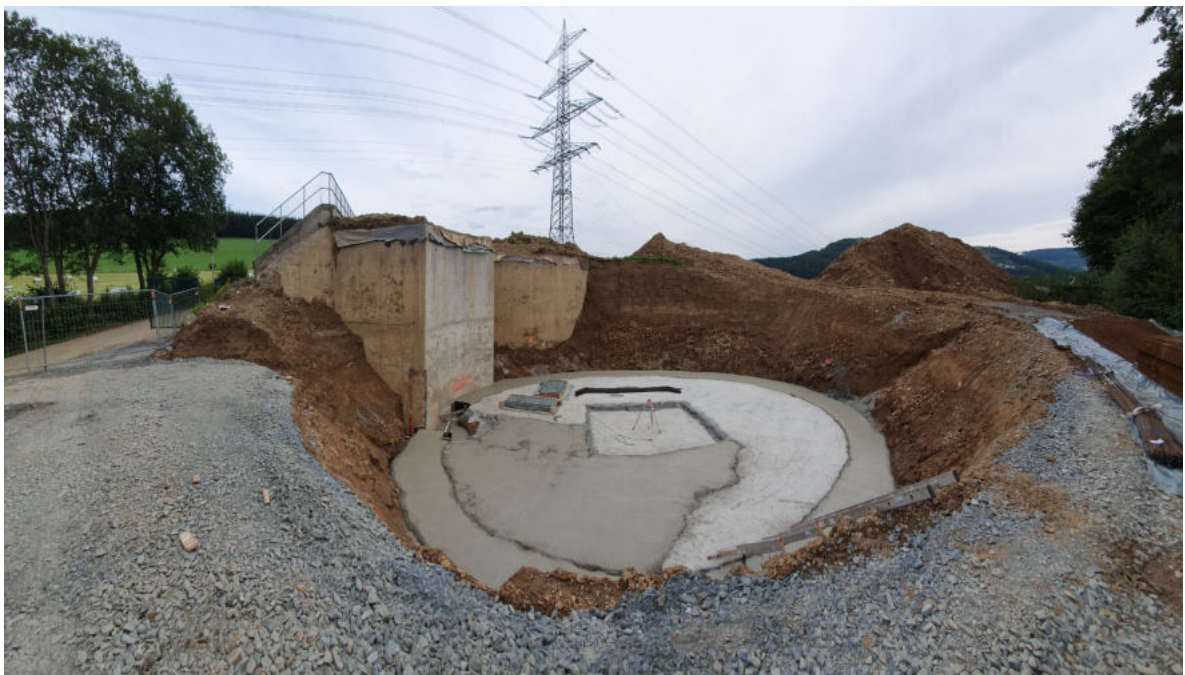
Neubau 2. Speicherkammer Hochbehälter Halbeswig
