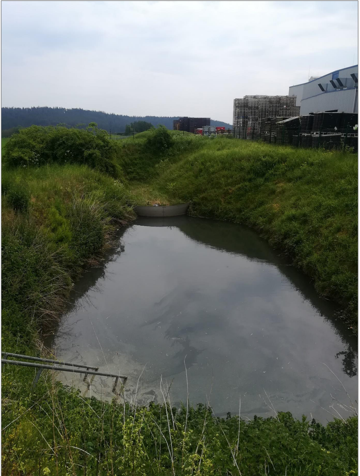
Abbildung 12: Regenrückhaltebecken im Nordwesten des bestehenden Betriebsgeländes der Firma Borbet.
