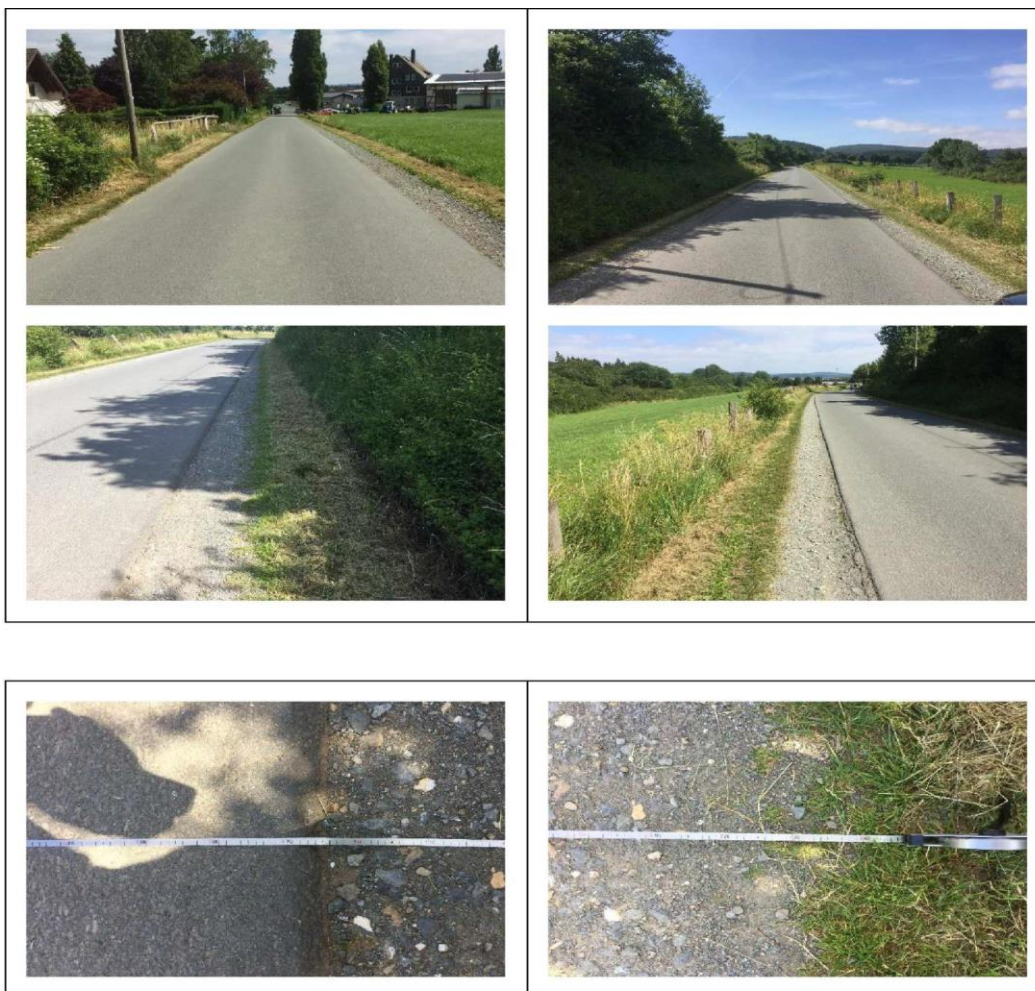
Abb. 40 — Vorhandener Straßenquerschnitt und die seitlichen Bankette
